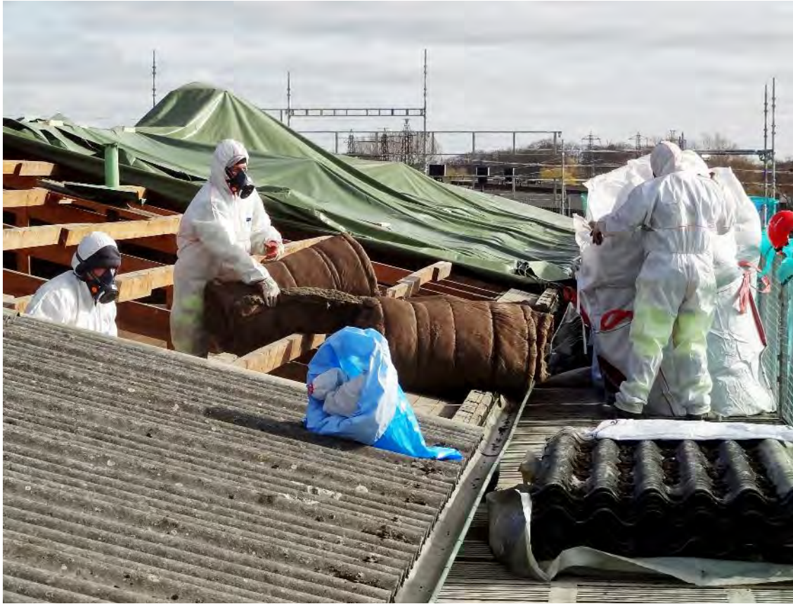
Figur 1. Rivning av tak med asbest
