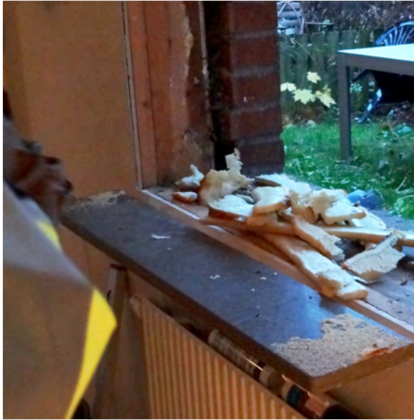
Figur 2 Fönsterbyte i en lägenhet
